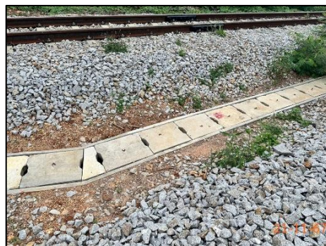
รูปที่ 2-4 รางระบายน้ำบริเวณพื้นที่ก่อสร้าง
