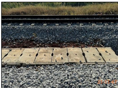
รูปที่ 2-4 รางระบายน้ำบริเวณพื้นที่ก่อสร้าง
