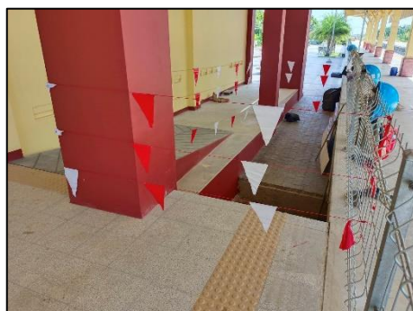
รูปที่ 2-14 การกั้นพื้นที่เขตก่อสร้าง การติดตั้งป้ายเตือน และสัญญาณไฟ
